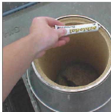
**24. Шов между внутренней керамической трубой и конусом уплотните специальным силиконовым герметиком Hermesil.**
