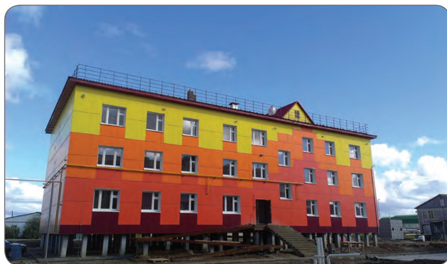
Новый Уренгой, пос. Тазовский Жилой 3-х этажный дом Решение SCHIEDEL: QUADRO
